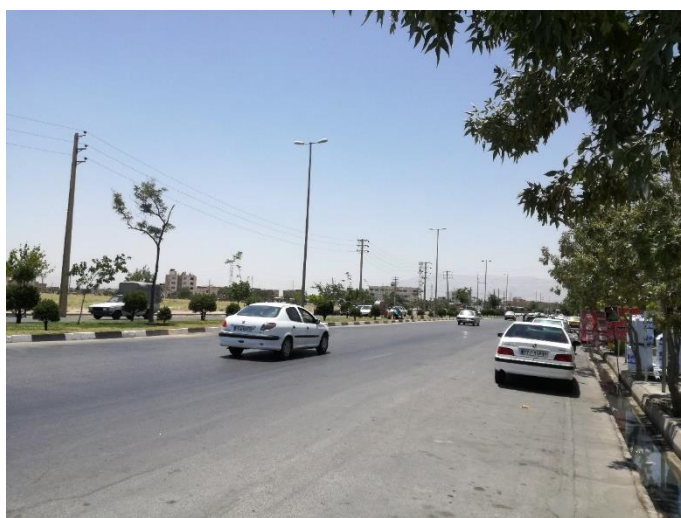
شکل ۷-۷۱- عکس مقطع شماره ۳۱ مسیر خط انبوه بر ۵
