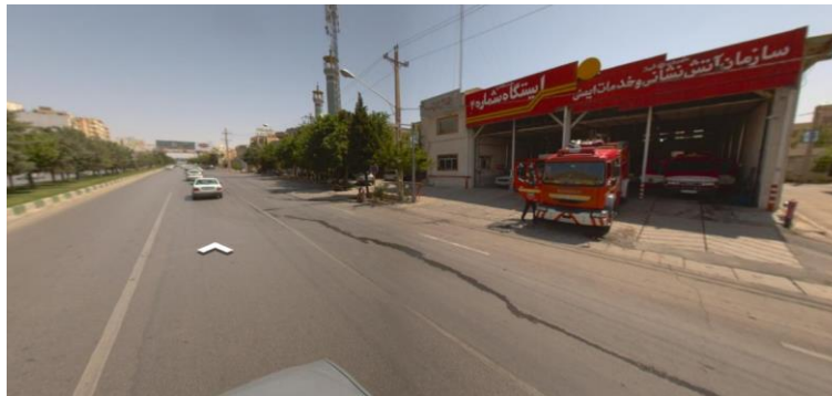
شکل ۹-۱۸- ایستگاه آتش‌نشانی واقع در بلوار شهید رجایی
