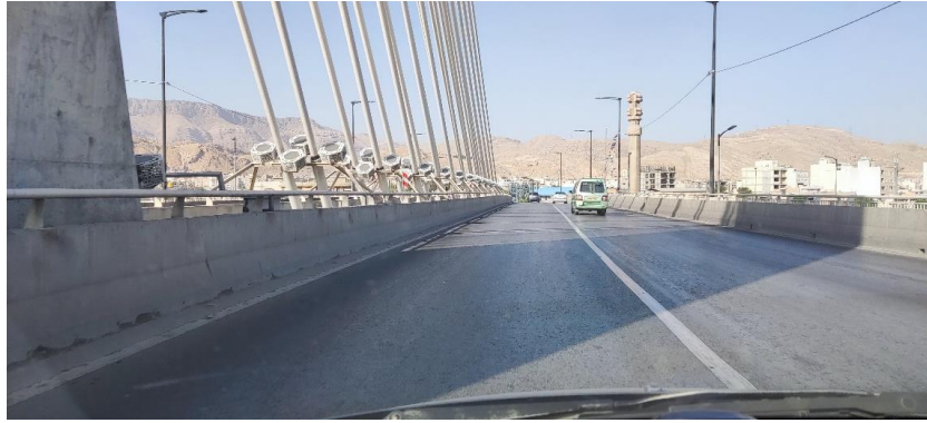
شکل ۹-۶۱- پل کابلی ولیعصر
