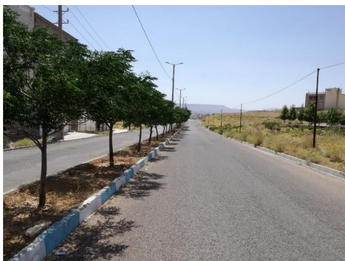
شکل ۷-۱۳۸- عکس مقطع شماره ۱۴ مسیر خط انبوه بر ۷
