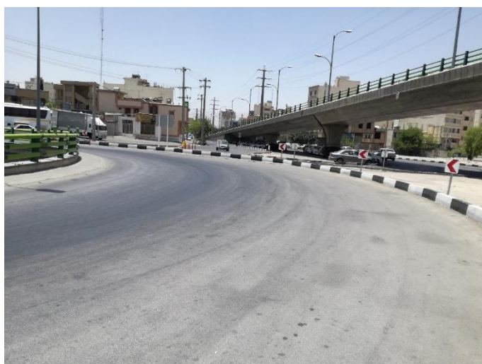
شکل ۷-۴۳- عکس مقطع شماره ۵ مسیر خط انبوه بر ۵
