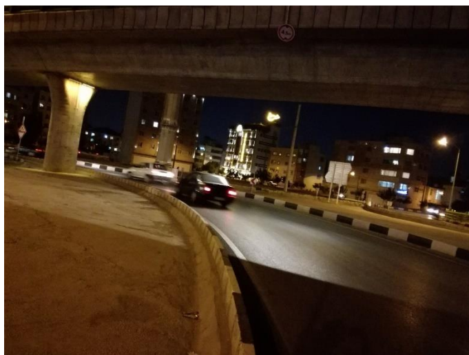
شکل ۷-۵۴- عکس مقطع شماره ۱۵ مسیر خط انبوه بر ۵
