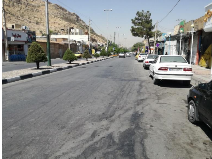
شکل ۷-۳۹- عکس مقطع شماره ۱ مسیر خط انبوه بر ۵
