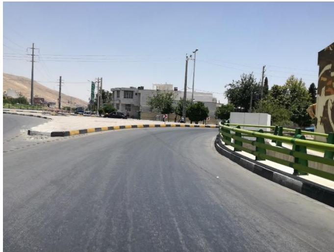
شکل ۷-۴۶- عکس مقطع شماره ۸ مسیر خط انبوه بر ۵
