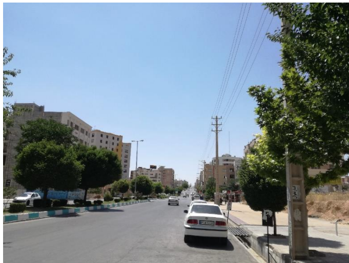
شکل ۷-۱۳۲- عکس مقطع شماره ۸ مسیر خط انبوه بر ۷
