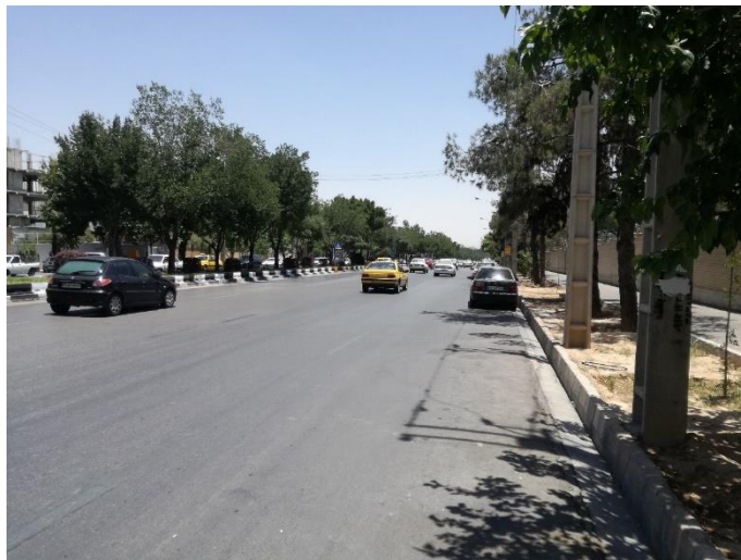
شکل ۷-۱۱- عکس مقطع شماره ۵ مسیر خط انبوه بر ۴
