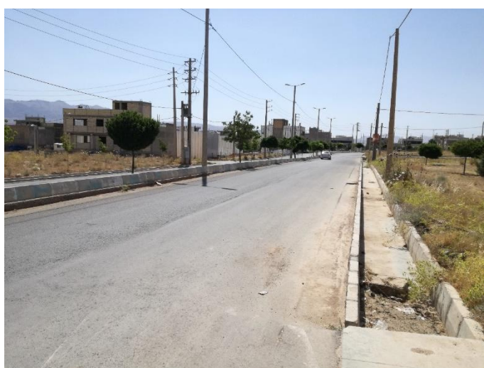
شکل ۷-۱۳۹- عکس مقطع شماره ۱۵ مسیر خط انبوه بر ۷
