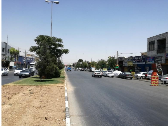
شکل ۷-۸۳- عکس مقطع شماره ۱ مسیر خط انبوه بر ۶
