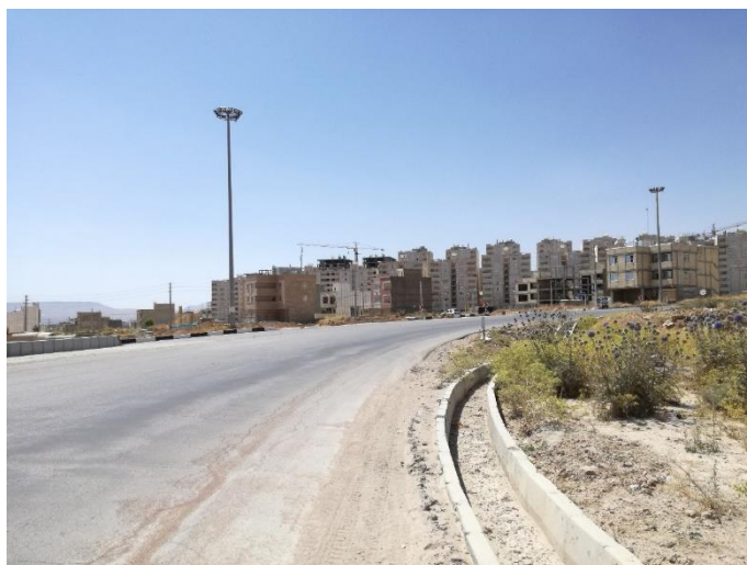
شکل ۷-۱۳۴- عکس مقطع شماره ۱۰ مسیر خط انبوه بر ۷
