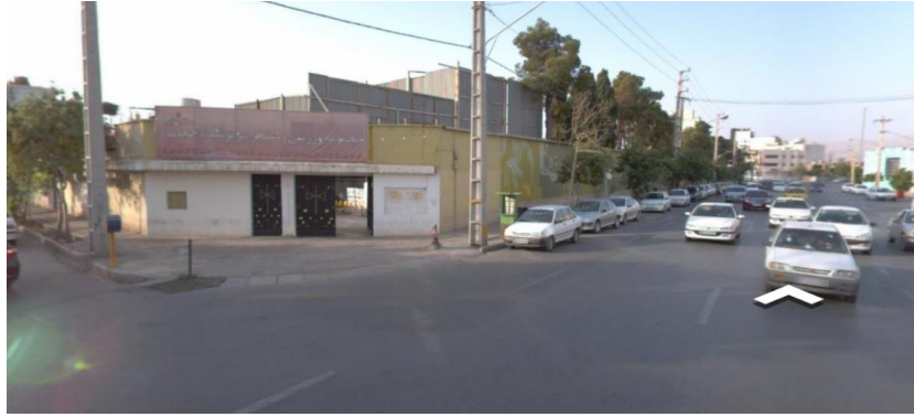
شکل ۹-۹۳- مجموعه ورزشی حجاب در خیابان بعثت
