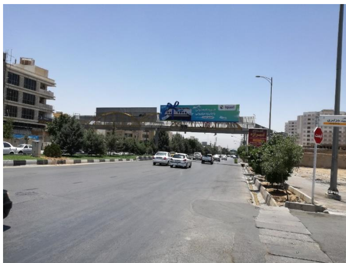
شکل ۷-۷- عکس مقطع شماره ۳ مسیر خط انبوه بر ۴
