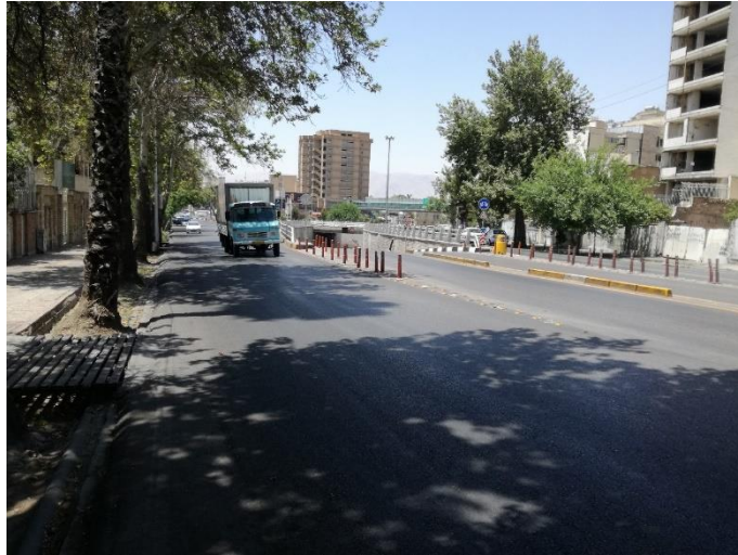
شکل ۷-۱۱۶- عکس مقطع شماره ۳۴ مسیر خط انبوه بر ۶
