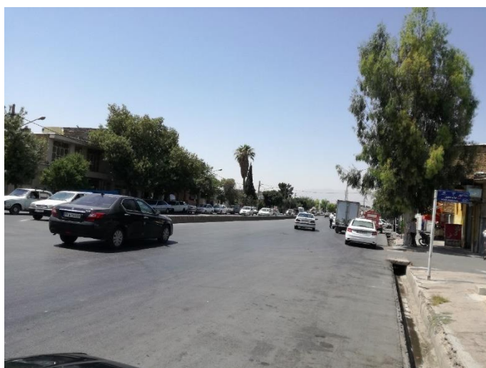
شکل ۶۵-۷- عکس مقطع شماره ۲۶ مسیر خط انبوه بر ۵
