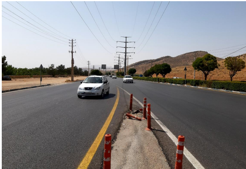
شکل ۹-۱۱۴- خطوط انتقال برق در جاده صدرا
