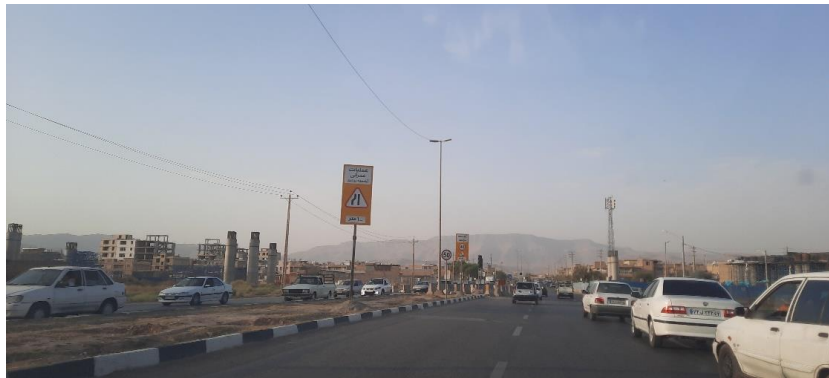
شکل ۹-۷۴- پل در حال ساخت انتهای بلوار نواب صفوی
