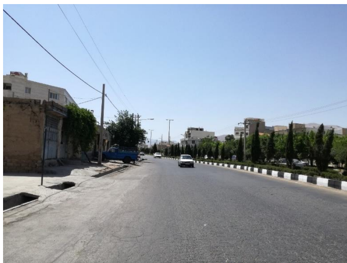
شکل ۷-۸۸- عکس مقطع شماره ۶ مسیر خط انبوه بر ۶
