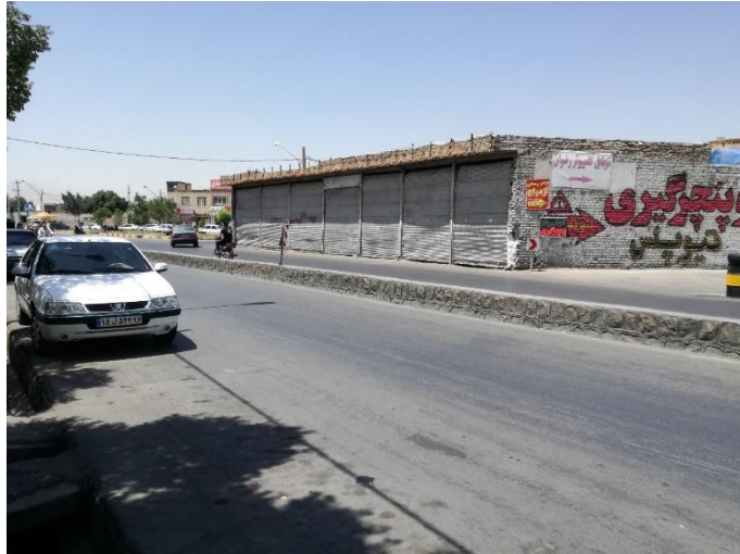
شکل ۷-۶۶- عکس مقطع شماره ۲۷ مسیر خط انبوه بر ۵
