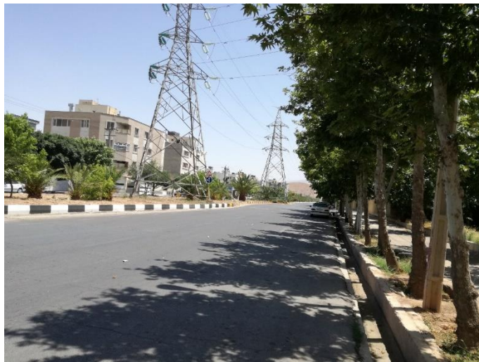
شکل ۷-۸۴- عکس مقطع شماره ۲ مسیر خط انبوه بر ۶
