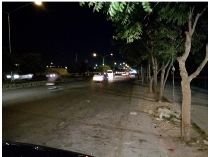
شکل ۶۴-۷- عکس مقطع شماره ۲۵ مسیر خط انبوه بر ۵
