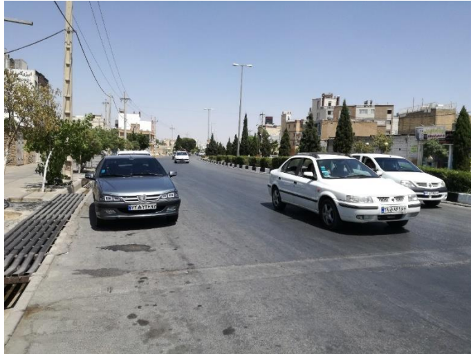
شکل ۷-۸۶- عکس مقطع شماره ۴ مسیر خط انبوه بر ۶
