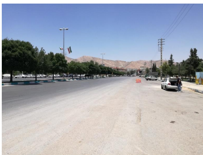
شکل ۷-۱۲۷- عکس مقطع شماره ۳ مسیر خط انبوه بر ۷
