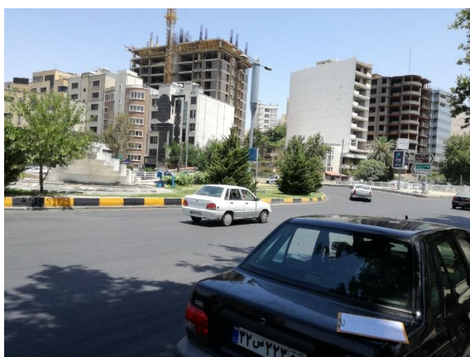
شکل ۷-۱۱۵- عکس مقطع شماره ۳۳ مسیر خط انبوه بر ۶
