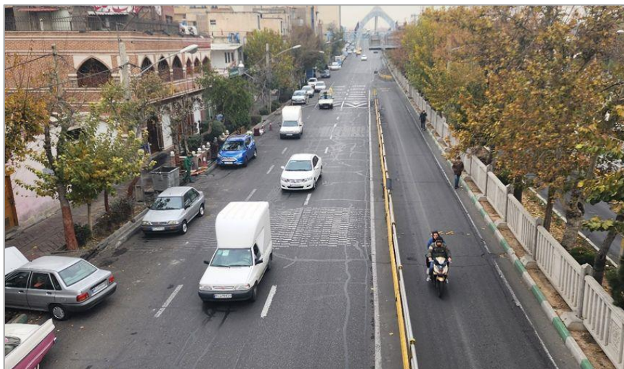
شکل ۱-۳- جداسازی خطوط ویژه به وسیله گاردریل
