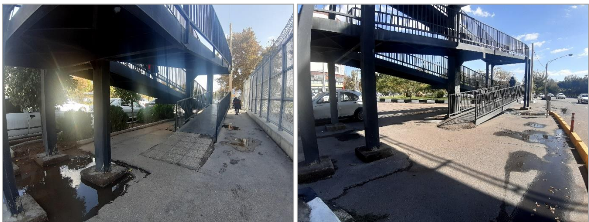
شکل ۴-۸- پیاده‌رو و پل هوایی در محل ایستگاه پارک قوری (رفت و برگشت)
