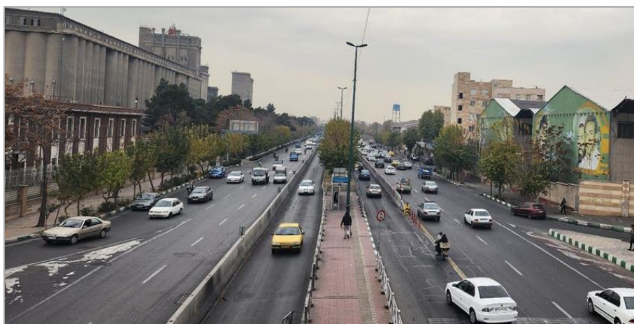
شکل ۲-۳- جداسازی خطوط ویژه به وسیله نیوجرسی
