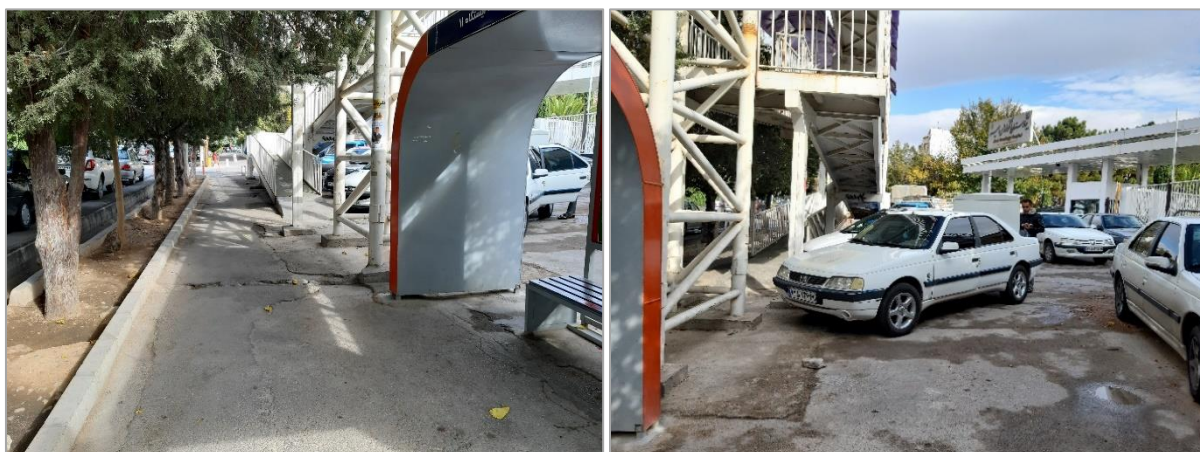
شکل ۴-۴- پل هوایی و پیاده‌رو موجود در ایستگاه بیمارستان امیر (مسیر برگشت)
