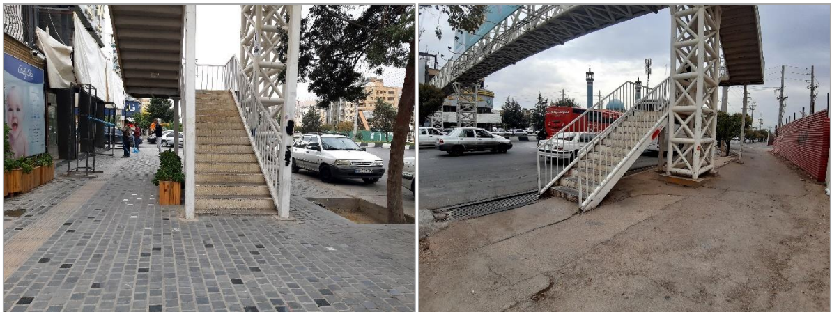
شکل ۴-۷- پیاده‌رو و پل هوایی در محل ایستگاه سجادیه (رفت و برگشت)
