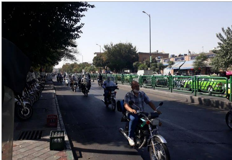
شکل ۳-۴- جداسازی خطوط ویژه به وسیله ترکیب جدول و نرده آهنی
