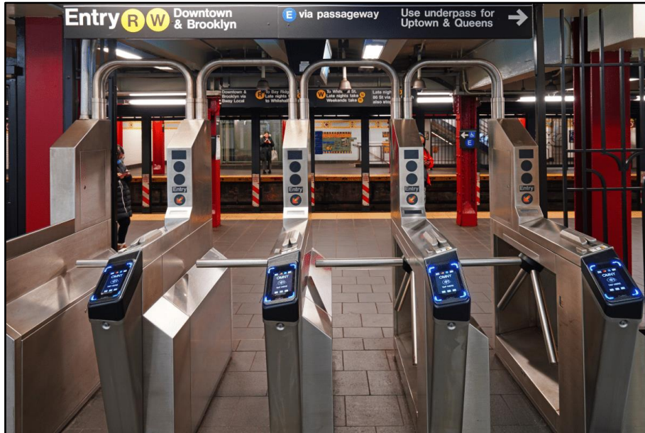
شکل ۳-۱۶- نمونه‌ای از دروازه‌های ورودی هوشمند نصب شده در یک ایستگاه مترو [۱۹]
