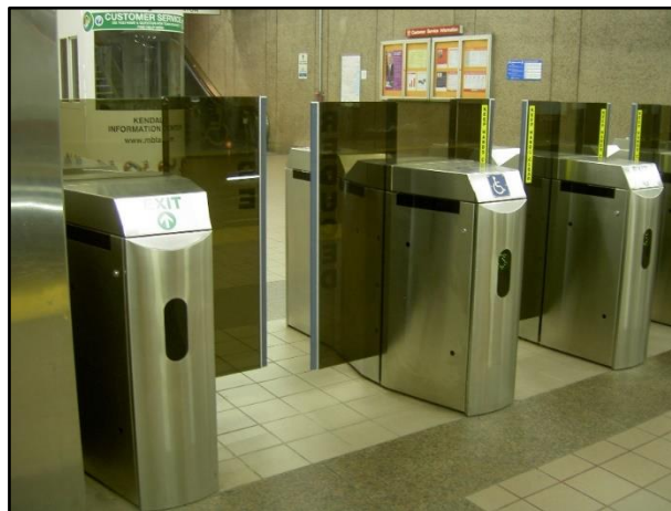
شکل ۳-۲۲- دروازه‌های ورودی خودکار با شیشه‌های کشویی [۲۳]
